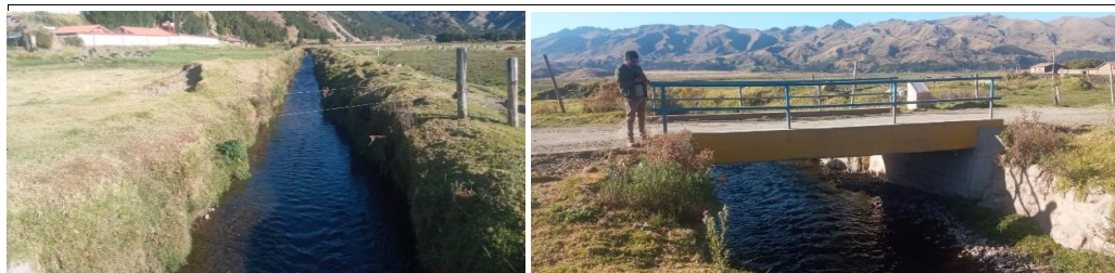
FOTO 01: Inicio de identificación de punto crítico Rio POMACANCHI. Cauce colmatado y estrangulado, talud natural Localidad sector San Jose de
